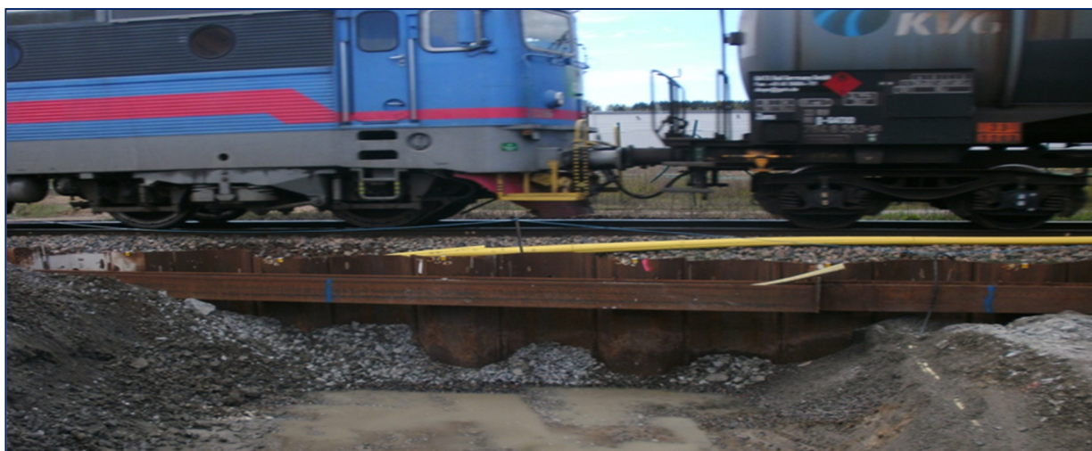
Figur 1. De studerade schaktetapperna. Övre bilden: Delsträckan utan hammarband. Undre bilden: Delsträckan med hammarband.
